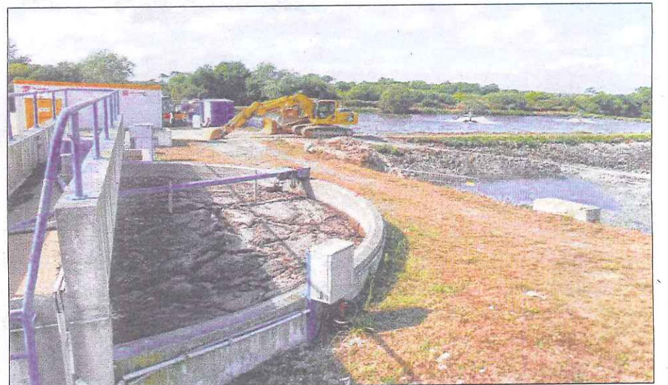
La station d'épuration de Plouharnel, dont les travaux ont commencé la semaine dernière, devrait être opérationnelle en juin prochain.
